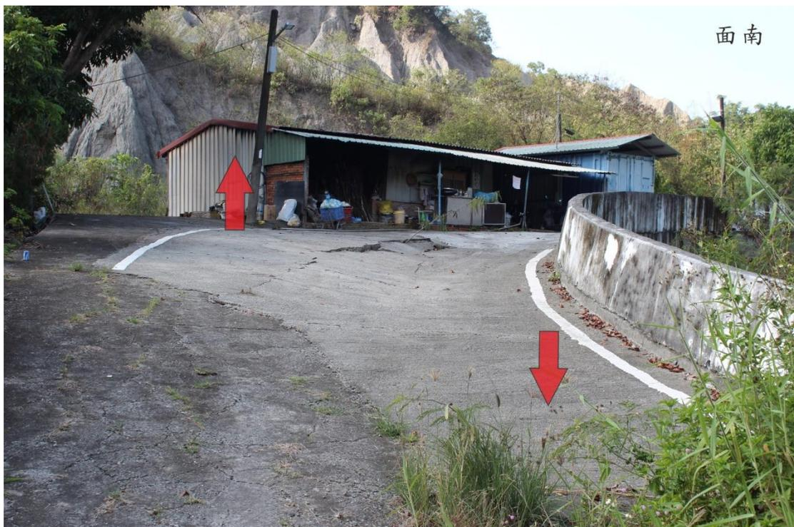
圖 48 車瓜林斷層於南勢湖露頭北側下方之道路有明顯破壞的跡象。東側相較西側於有明顯的抬升跡象，面南拍攝。
